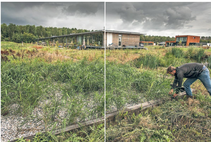
Het holofytenfilter in Almere Oosterwold; een rietsveldje in een bak met schelpen, zand, grind en ijzersubstanties.
